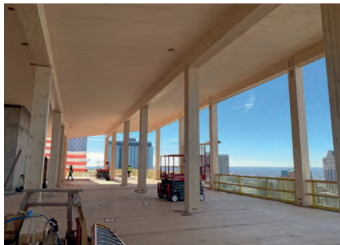
FOTO: THORNTON TOMASETTI
